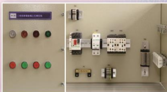
第7題 三相感應電動機正反轉控制
