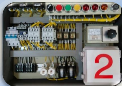
三相感應電動機Y- \Delta 降壓控制
