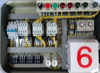
三相感應電動機順序啟閉控制
